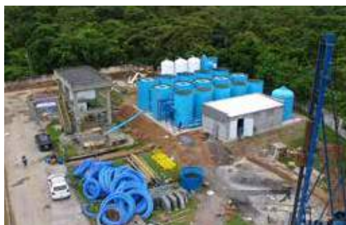
Registros das obras da Estação de Tratamento de água (ETA) da Barra do Sahy, com capacidade de 60 L/s como projeto de reconstrução de São Sebastião da Companhia.
