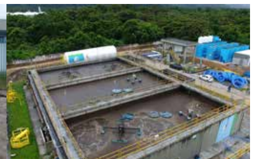
Registros das obras da Estação de Tratamento de água (ETA) da Barra do Sahy, com capacidade de 60 L/s como projeto de reconstrução de São Sebastião da Companhia.
