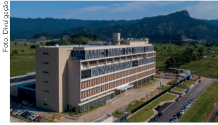
O prédio conta com seis pavimentos, 10 consultórios e 228 leitos para atendimentos, centro cirúrgico, UTI, hospital dia, internação e exames em diversas especialidades médicas.
