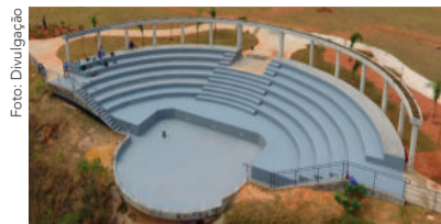
Até o momento já foi realizada toda a pavimentação do acesso, estacionamento, implantação do teatro de arena e iluminação do local.
