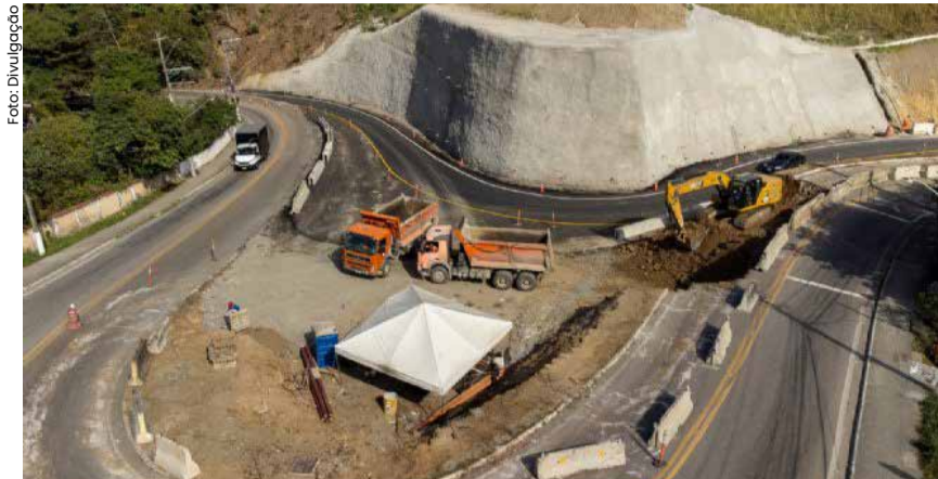
De acordo com a Artesp, o trecho da obra que liga Caraguatatuba e São Sebastião será entregue em novembro de 2024, com data ainda a ser divulgada, e contará com novo sistema de pedágio "Free Flow".
