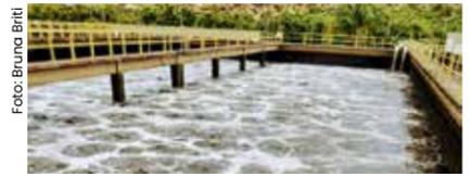
Tanque de aeração de tratamento de esgoto em Caraguá
